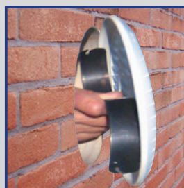
tirare ruotandola in senso antiorario
